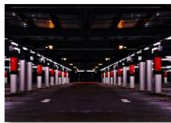
立体駐車場・消防設備
